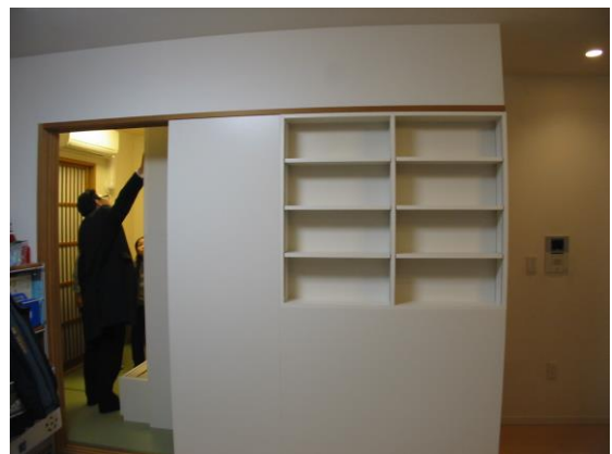
リビングのふすまを外してオープン棚付間仕切り
