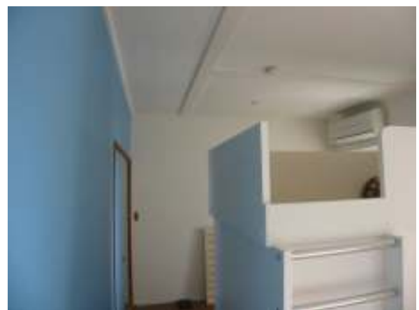
天井は区割りに沿ってカーテンレール下地を設置
