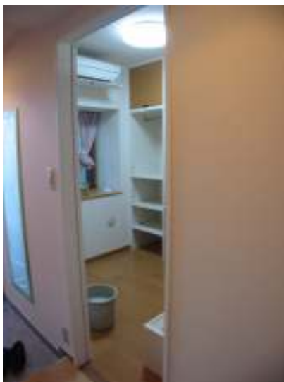
玄関框ぎりぎりに片引戸新設
