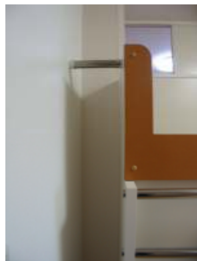
壁と20センチの隙間にハンガーパイプ
