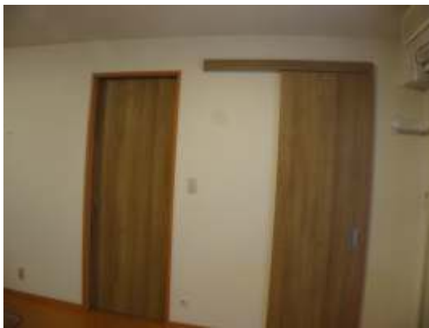
右側ドアは片開を片引に、左は新設片引戸
