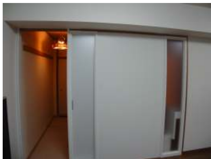
リビングとの間仕切りパネル、片引戸 畳はカットして再使用
