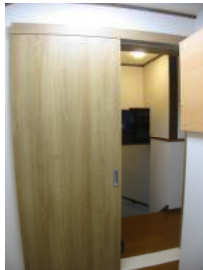
片引戸を新設
