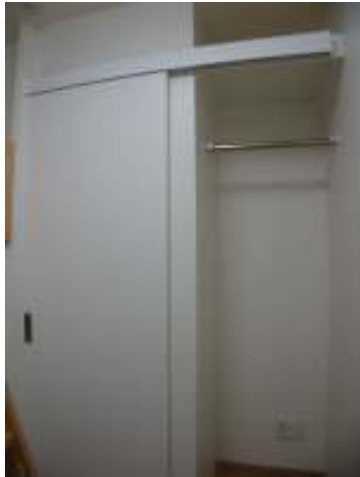
既存の片開扉の内に片引戸とクローゼットを新設
