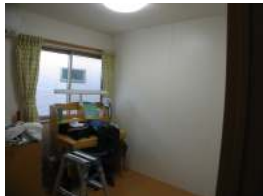
4帖半は間仕切りパネルで囲いました
