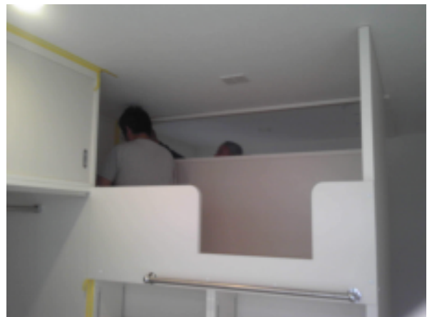
奥の間仕切はカーテンが吊るせるように カーテンレール受け地板を天井に設置
