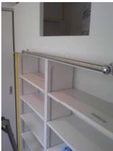
2階側梯子受けパイプ
