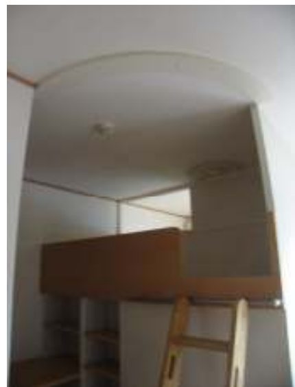
2階ベッド側、天井に曲線のカーテン下地
