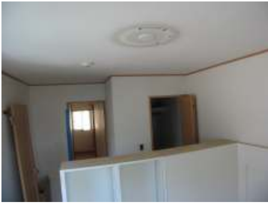
工事の途中、右側の開口を撤去
