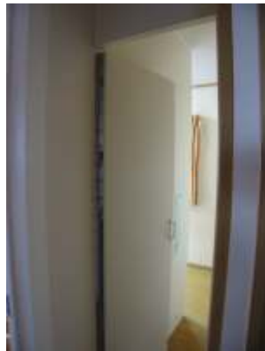
2階側への通路に片開ドア新設
