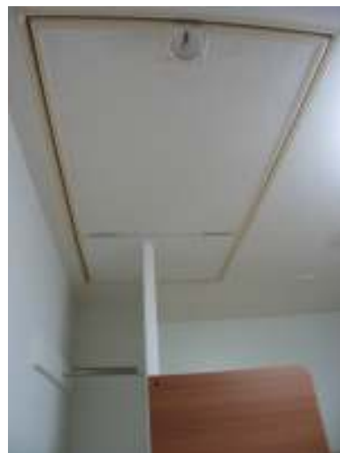
ロフト天井蓋の1/3を固定に改造
