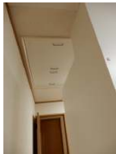
天井ロフト用梯子は撤去し上げ蓋新設
