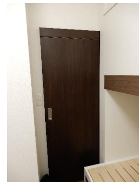
1階側の扉は新設片開き扉
