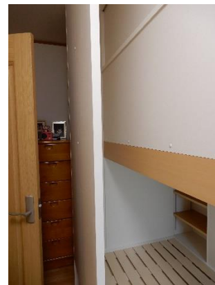
既存ドアから1階部分が見えないようにパネルで遮蔽
