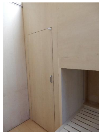
間仕切りパネルに片開き戸を付ける
