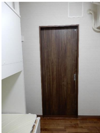
片開きドアを廊下側に新設
