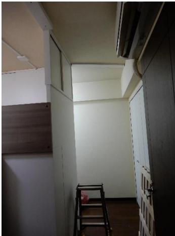
共用通路巾は1m確保、上部は既存エアコン
