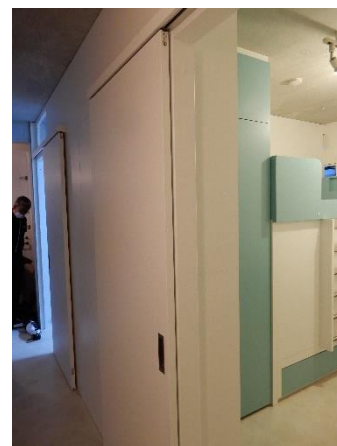
廊下から見た新設間仕切と片引き戸
