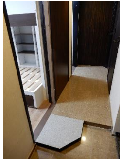
玄関傍の引き戸の位置を手前に移動 玄関タタキに置床設置
