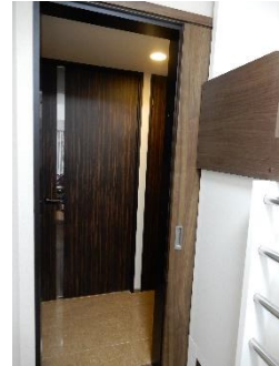
2階側の入り口は壁に穴あけ新規に 引き戸設置
