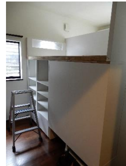
2階ベッド側の手摺を付ける前の内部
