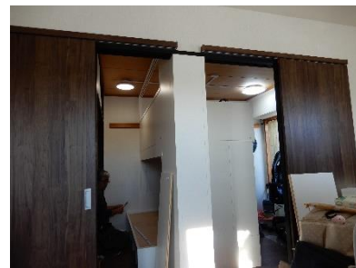
障子を撤去して片引戸 2枚で入り口を左右に新設
