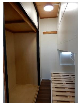
押入中段撤去して1階側スペースを拡張
